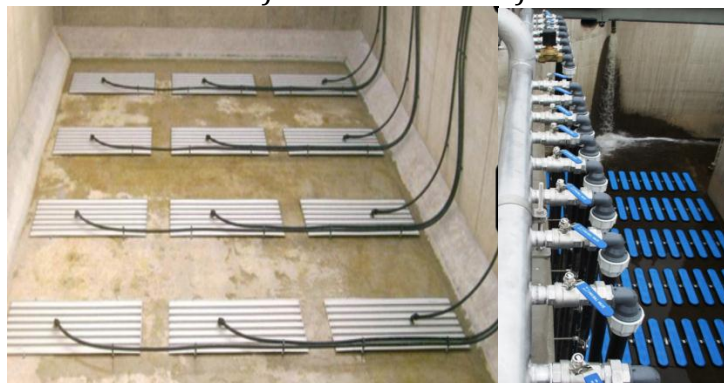
Slika 13: Pločasti difuzori sa visokom efikasnošću unosa O_2
