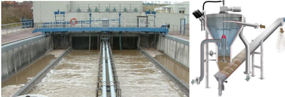
Slika 11: Podužni aeracioni pjeskolov/mastolov kao betonski rezervoar (Gotha, Njemačka), lijevo, ispirać pijeska (desno)
