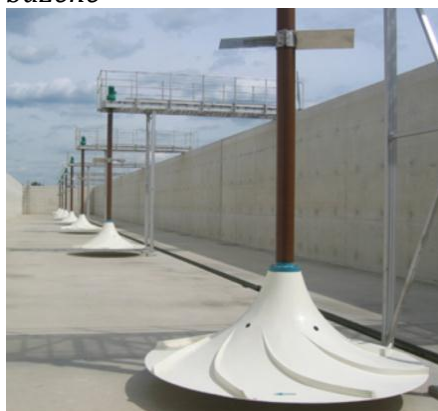
Slika 12: Tip miksera koji štedi energiju za neaeracijske odjeljke, anoksične i anaerobne bazene
