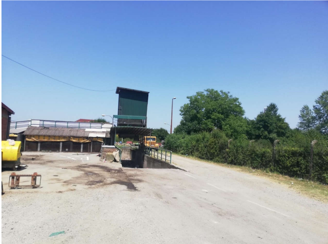
Слика бр.л.1: Трансфер станица КП „Градска чистоћа“ а.д. Градишка
