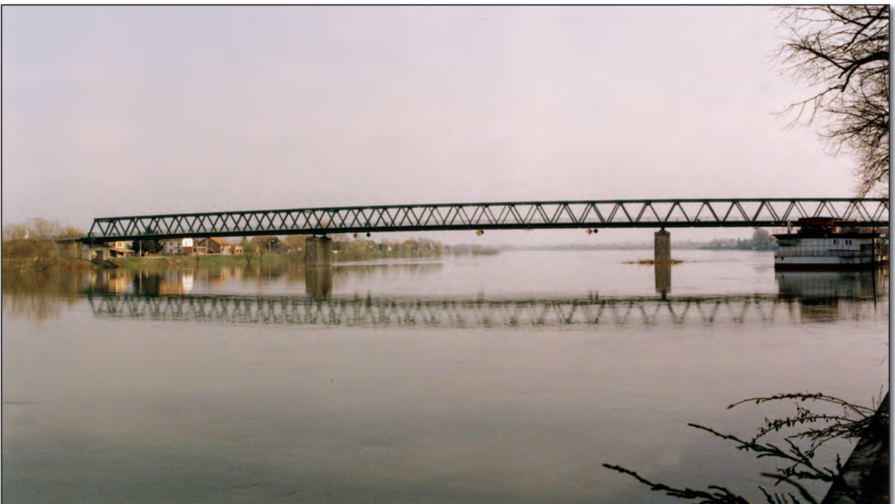
Савремени мост преко ријеке Саве у Босанској Градишци, пуштен у саобраћај 1956. године Contemporary bridge via the river Sava in Bosanska Gradiška, put into operation in 1956
