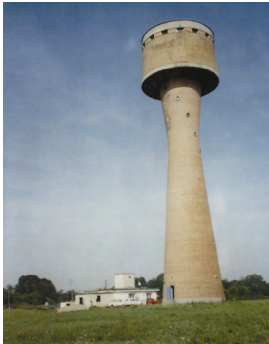
Водоторањ у Босанској Градишци пуштен у рад 1966. године
